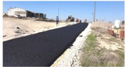
Veien har fått asfalt
