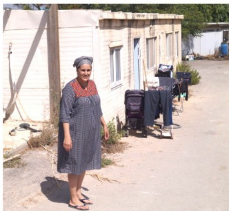
Ilana foran huset sitt. Huset har hatt lekkasjer fra taket og gulvene råtner.
